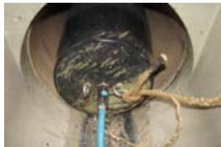
Mise en place d'un obturateur sur canalisation
