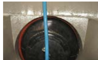
Obturation d'une canalisation par ballons
