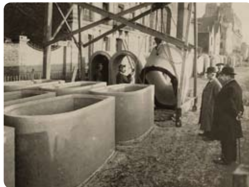
Exemple de canalisation ancienne toujours en service en 2010
