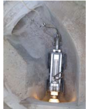
Caméra d'inspection sur chariot motorisé
