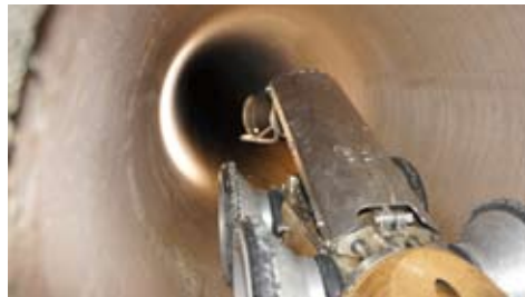
Caméra d'inspection sur chariot motorisé
