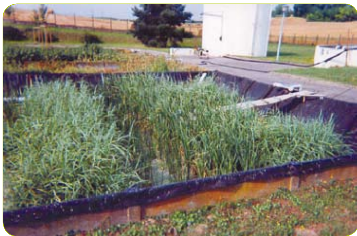
► Exemple de filtres plantés dans le Bas-Rhin (Berstett)
