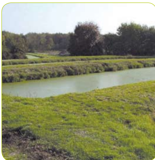
► Exemple de bassins de lagunage à Rochefort
